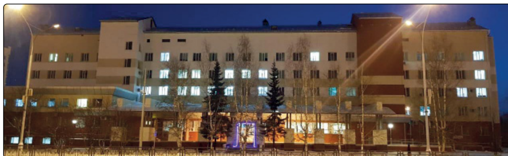
Здание акушерского стационара перинатального центра
